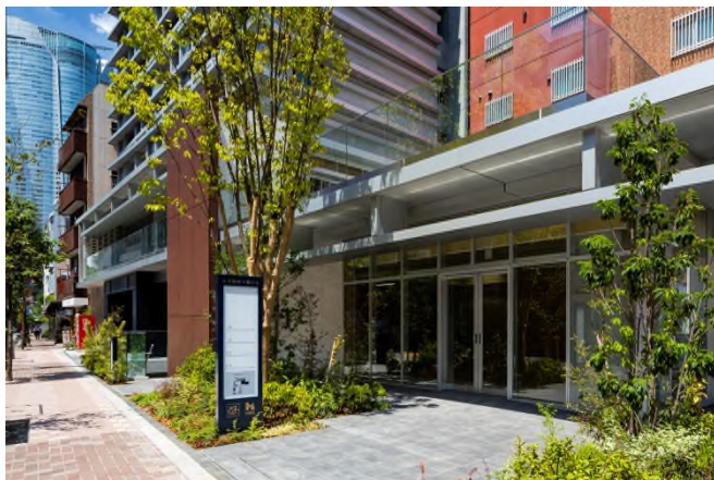
[ 「ルネ麻布十番ビル」の1階、2階テラス写真 ]
